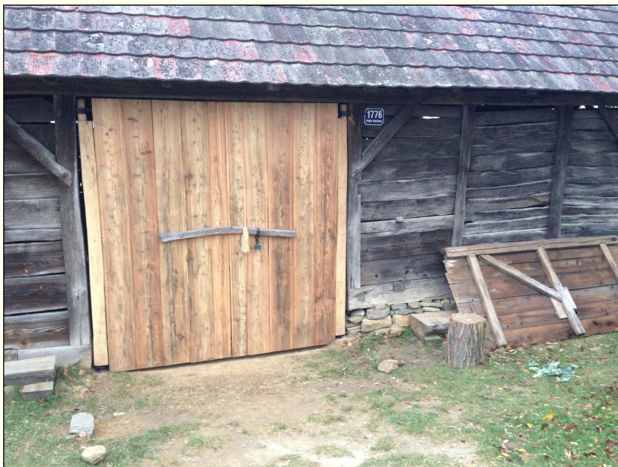
Vrata stodoly po rekonstrukci
