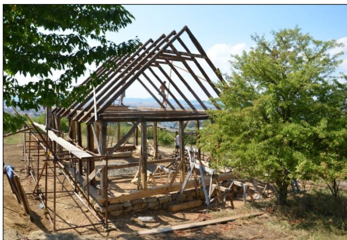
Obr. č. 4: Výstavba historické stodoly z Břestku na Rochusu
